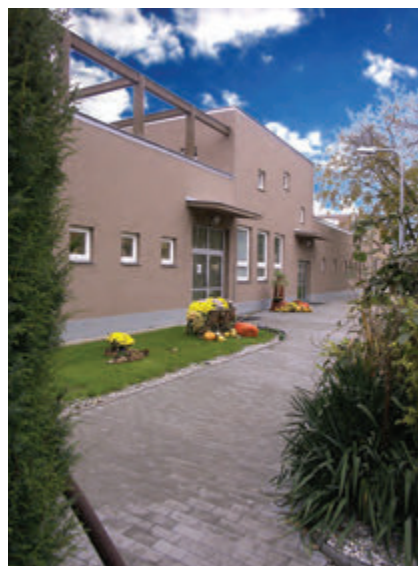
Budova nové haly
