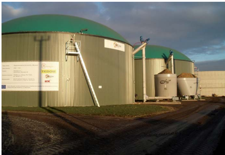
Bioplynová stanice se skládá ze dvou paralelně provozovaných fermenterů. Výkon BPS je 495 kW (foto: CZ Biom).
