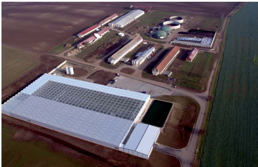
Letecký snímek dokončené bioplynové stanice a navazujících skleníků (foto: CZ Biom).
