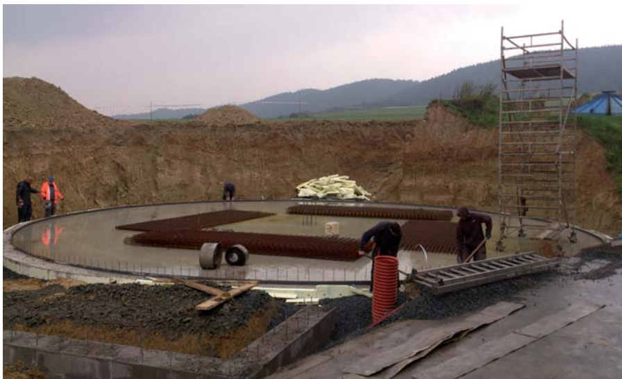
Výstavba fermentoru BPS o výkonu 170 kW (foto: CZ Biom).
