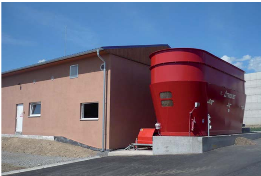
Technická budova BPS s vertikálním mixérem (foto: EnviTec Biogas).
