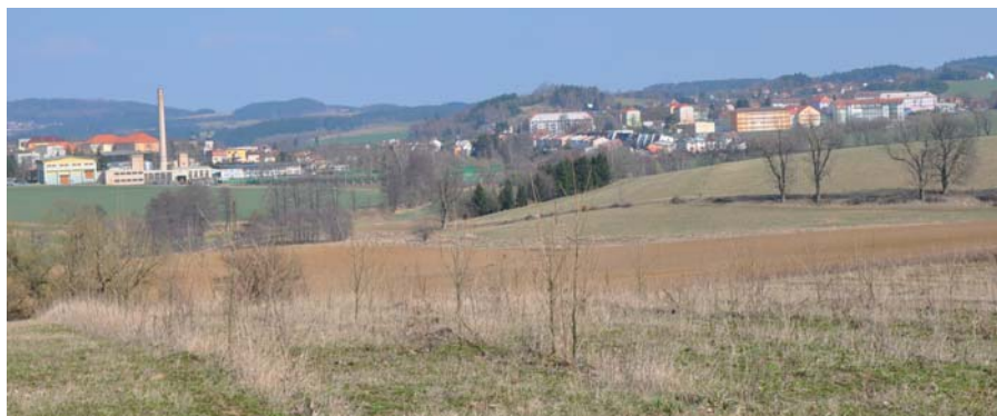
Výtopna na biomasu na Sídlišti II v Bystřici n. Pernštejnem s téměř 9 tisíci obyvatel. Dnes je na centrální rozvodě připojeno asi 60 % obyvatel.
