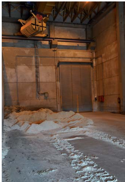
Kotelna využívá jako palivo hlavně dřevní odpad ve formě štěpky, pilin a kůry z pilařských provozů, ale i cíleně pěstovanou biomasu.
