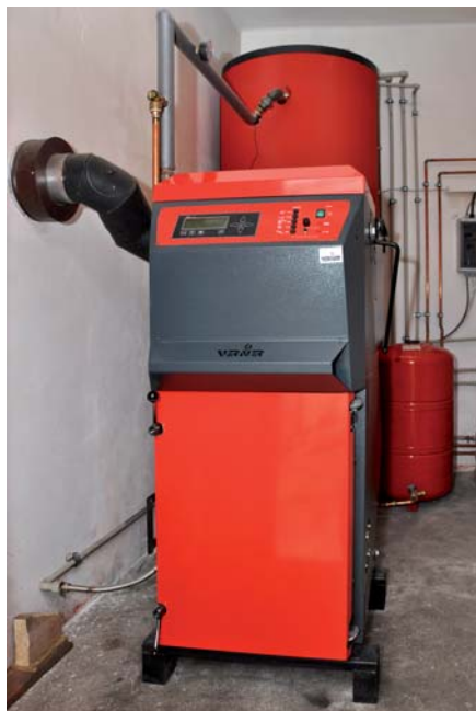
Automatický kotel na pelety, agropelety a obilí VERNER A25 I o výkonu 25 kW. Kotel splňuje emisní třídu 5.
