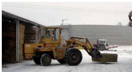
V topném období roku je z kotelny na biomasu dodáno 1 600 MWh do rozvodu tepla v Kněžicích.
