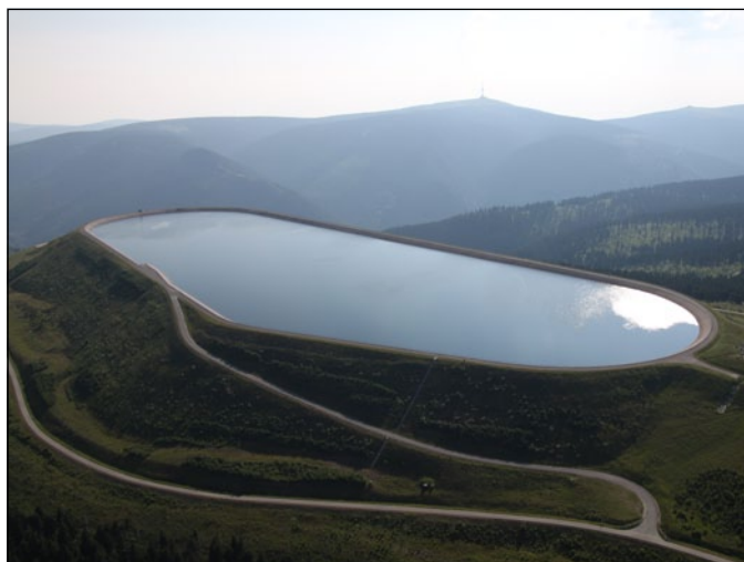
Přečerpávací vodní elektrárna Dlouhé Stráně
