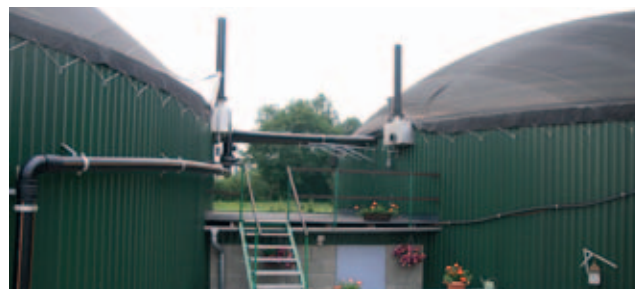
Farma rodiny Basařových, Prosečné, okres Trutnov, chov skotu, bioplynová stanice (projekt PRV – stavba bioplynové stanice)
