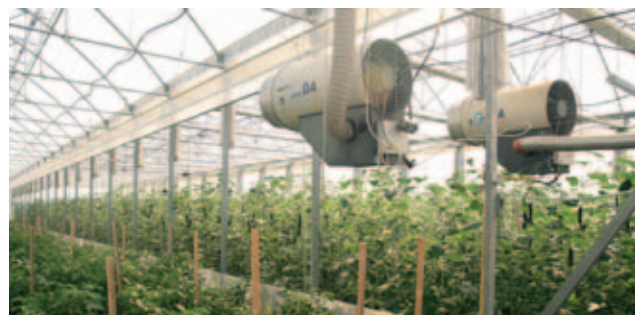
Zahradnictví Nedělník, Otaslavice, okres Prostějov, zahradnictví, zelenina 50 ha, (projekt PRV – stavba fóliovníku, sklad zeleniny)
