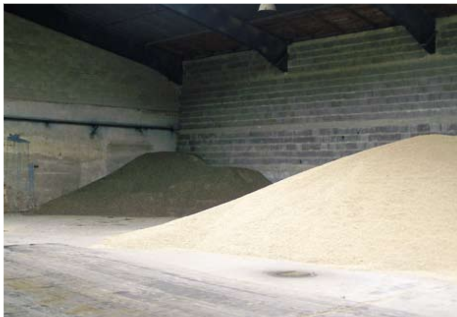
Nevhodné skladování surovin
